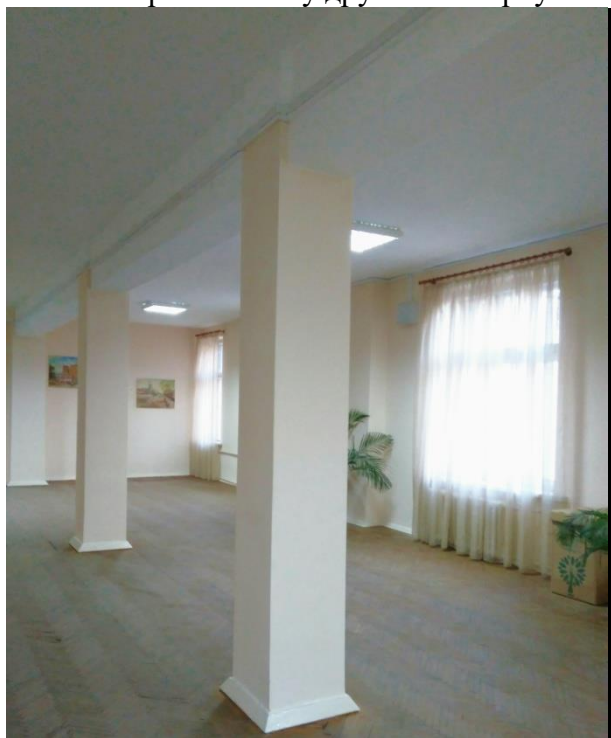
Поточний ремонт холу другого поверху
