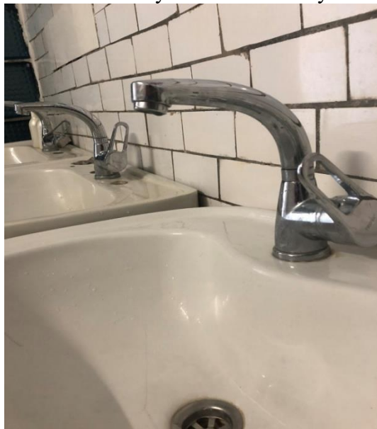
Замінено в санвузлах на кожному поверсі нові крани
